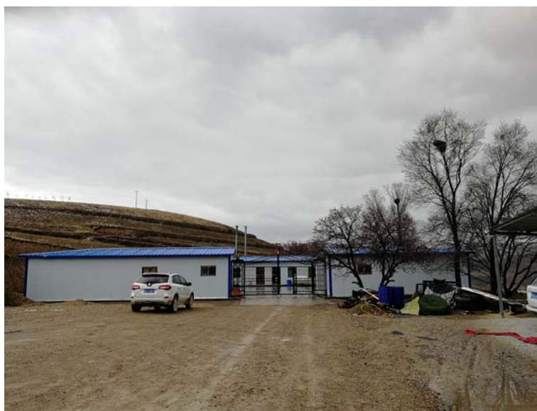
照片 1-2 生活区照片（镜向南）
