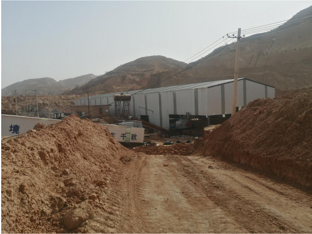
照片 1-5 工业场地（原料车间）（镜向东）
