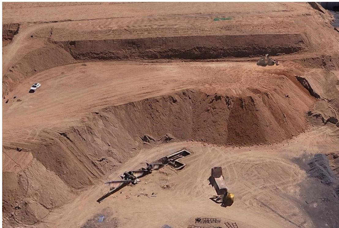
照片 2-6 旭鹏公司黄铎堡镇南城村四矿边坡恢复治理情况（镜向南）
